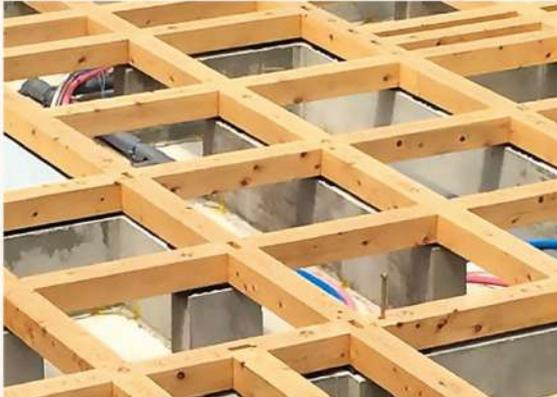
弊社の基礎は高耐久のベタ基礎仕様。鋼製束は使わずに910mmピッチで基礎コンクリートを立ち上げ、土台からがっちり家全体を支えます。土台、大引き、1階柱、通し柱には頑丈な桧材を使用しています。
